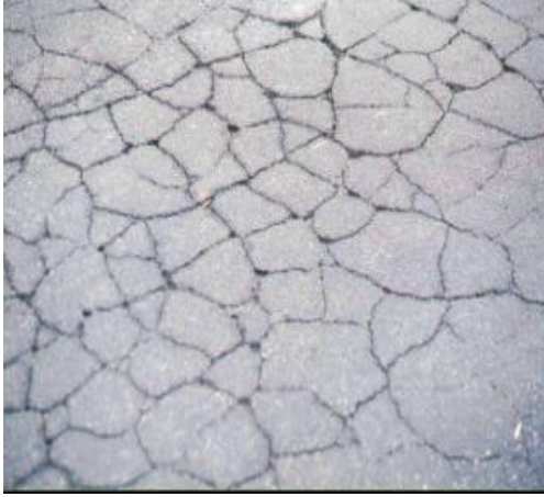
c) Agrietamiento térmico
