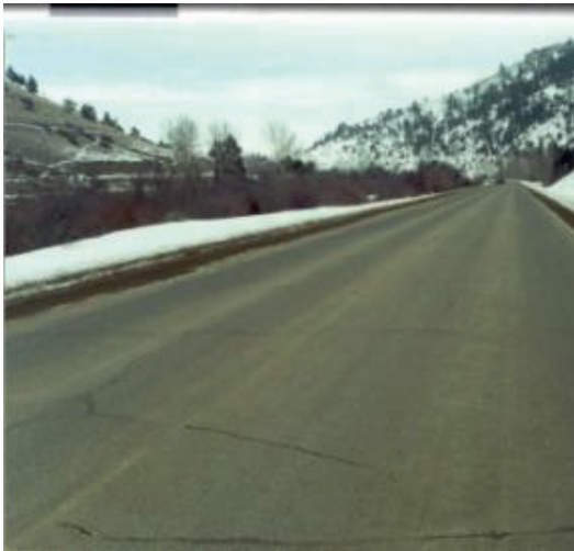
c) Agrietamiento térmico
