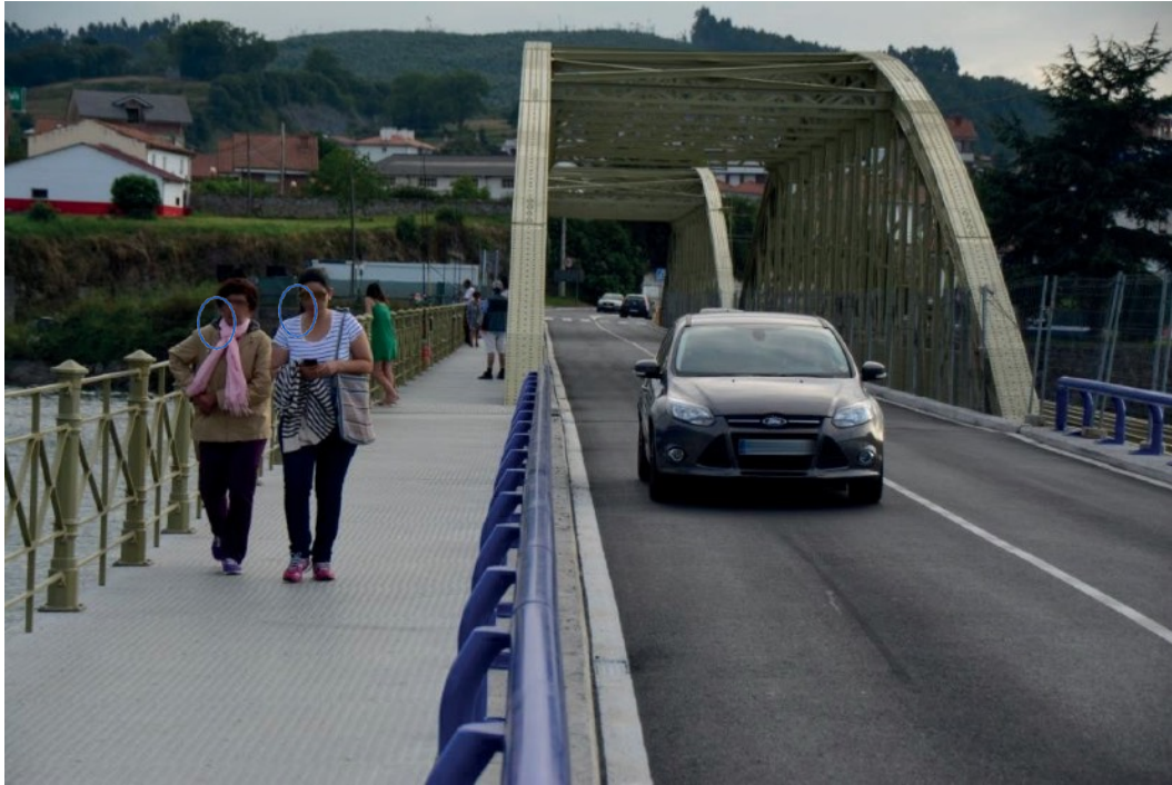
Figura 33. Sección rehabilitada (junio 2016) del puente metálico del tramo móvil con el sistema de contención urbano nivel H2 sobre la ría del Asón (Treto).
