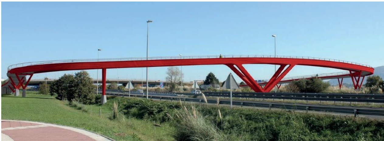
Figura 15. Vista general de la pasarela principal de sección mixta.
