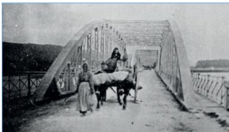
Figura 27. Puente Metálico sobre la ría del Asón tomada desde el estribo del lado de Bárcena de Cicero.
