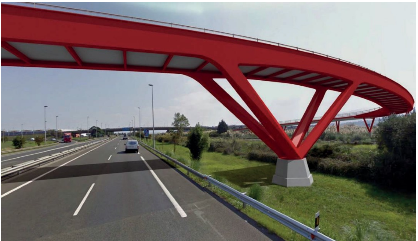
Figura 16. Vista de la losa de hormigón y la estructura metálica.
