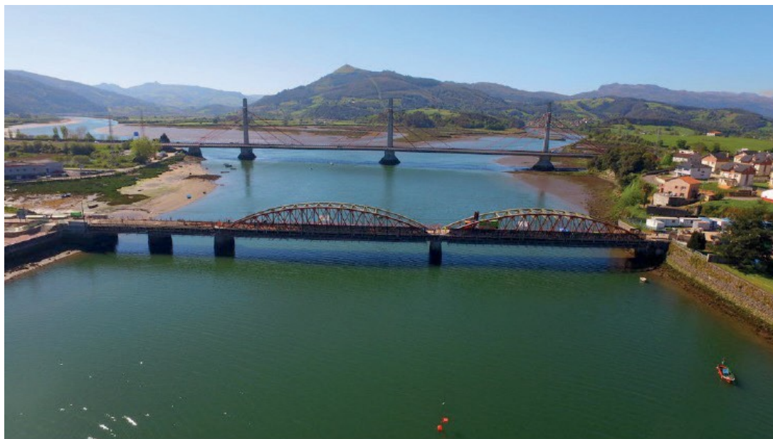
Figura 26. Vista general de la ría del Asón con la estructura (1995) de la autovía A-8 al fondo y el puente de Treto (1905) de la carretera N-634 en primer lugar.
